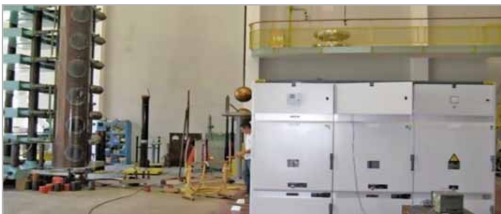
Tipaska ispitivanja postrojenja DELS-36 provedena su u svemu prema standardu IEC 62271-200 u akreditiranim laboratorijama KONČAR Instituta Zagreb, Hrvatska
