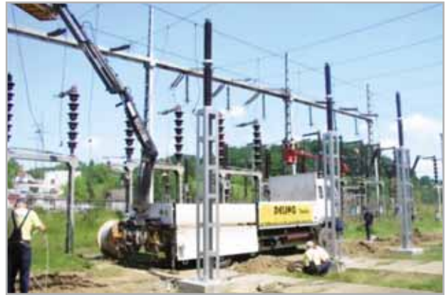
Instalacija nove 220kV opreme u rasklopno postrojenje
