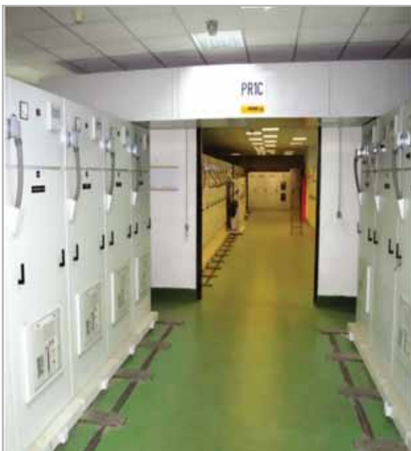
Postojeće postrojenje sa fiksnim malouljnim prekidačima
