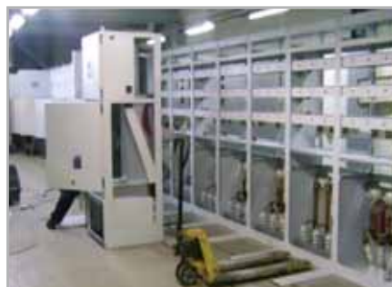
Postrojenje u fazi retrofita
