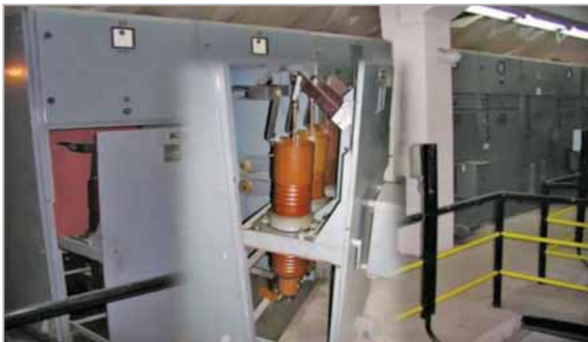
Postrojenje prije retrofita
