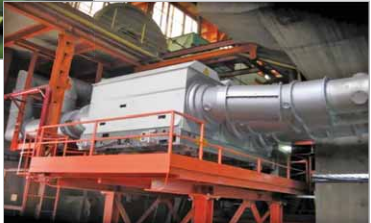
Ugradnja generatorskog prekidača (ABB) 9000A, 15kV i rekonstrukcija sabirnica Bloka 6 u "TE Kakanj"
