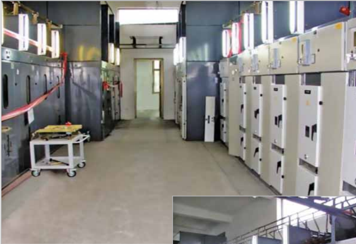
Lijevo: Stari dio postrojenja Desno: Dio postrojenja nakon retrofita
