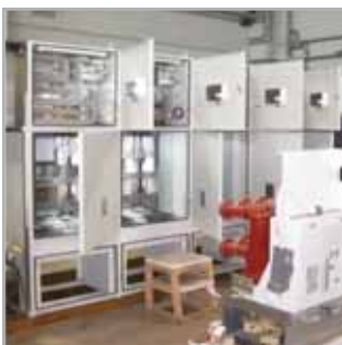
Postrojenje u fazi retrofita
