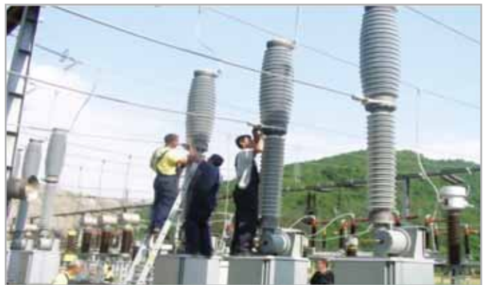
Instalacija novog prekidača 110kV i sabirničkog sistema; Rekonstrukcija 110kV rasklopnog postrojenja
