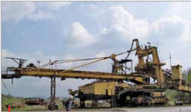
Rudnici lignita KREKA - Tuzla; Površinski kop Dubrave Bager SRs 402 prije početka rekonstrukcije
