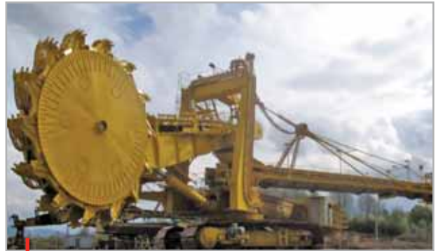
Bager SRs 402 nakon rekonstrukcije; Faza probnog rada svih funkcija bagera
