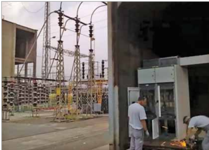
Priprema ćelija za testiranje otpornosti na luk (arc proof testing)
