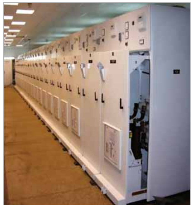
Izvlačivi dio ćelije nakon retrofita sa fiksnim prekidačem
