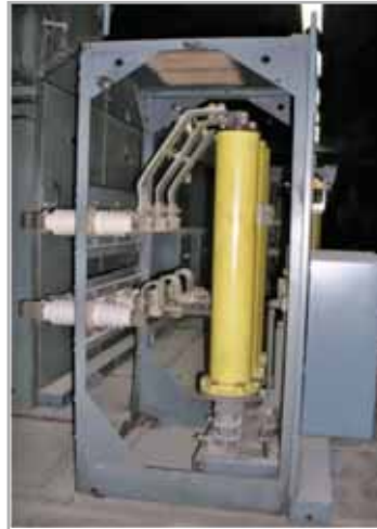
Izvlačivi dio ćelije sa fiksnim prekidačem,
