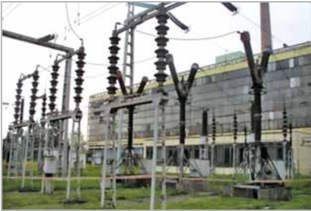
Staro 220kV rasklopno postrojenje prije rekonstrukcije
