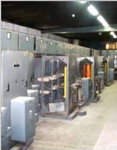
Postojeće postrojenje sa fiksnim malouljnim prekidačima
