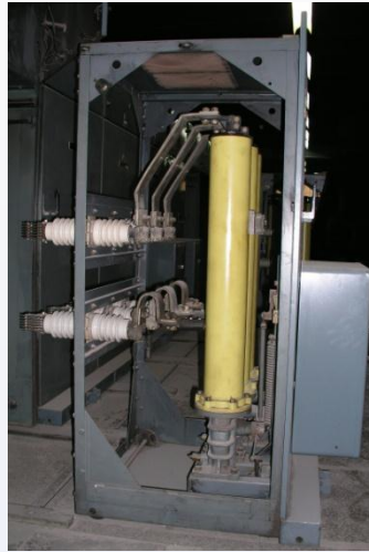
Izvlačivi dio ćelije sa fiksnim prekidačima, provodnim izolatorima i konektorom
