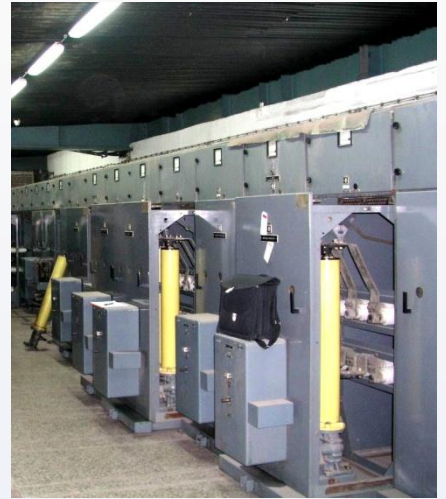
Izvlačivi dio ćelije sa fiksnim prekidačima, provodnim izolatorima i konektorom
