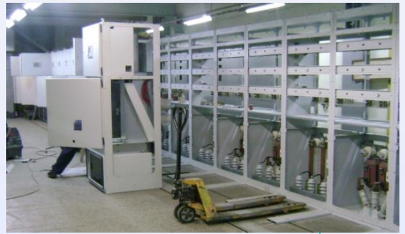
Postrojenje u fazi retrofita
